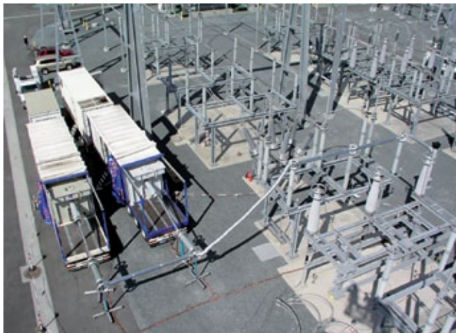
Рис. 3 Испытания кабеля на месте применения с использованием HiRES Locator и резонансной испытательной системы WRV 83/260 T
