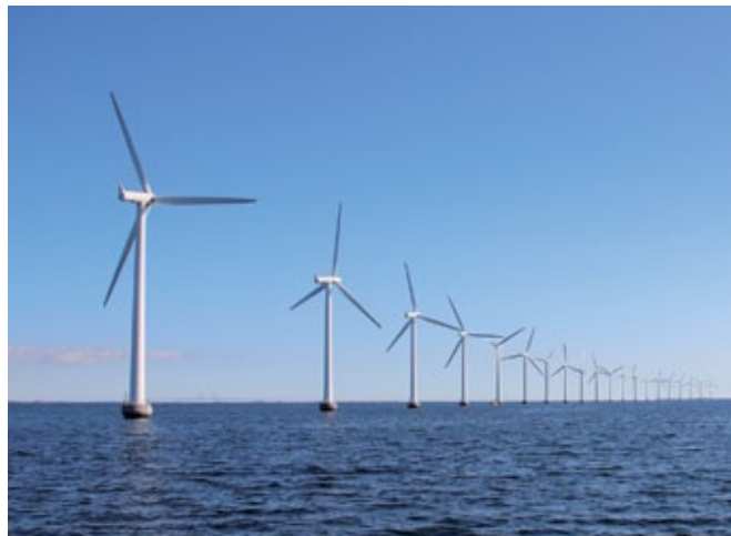
Рис. 4 Непрерывный мониторинг кабельных линий с помощью HiRES Locator
